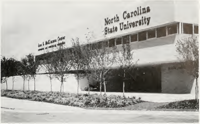
Jane S. McKimmon Center at NCSU.
